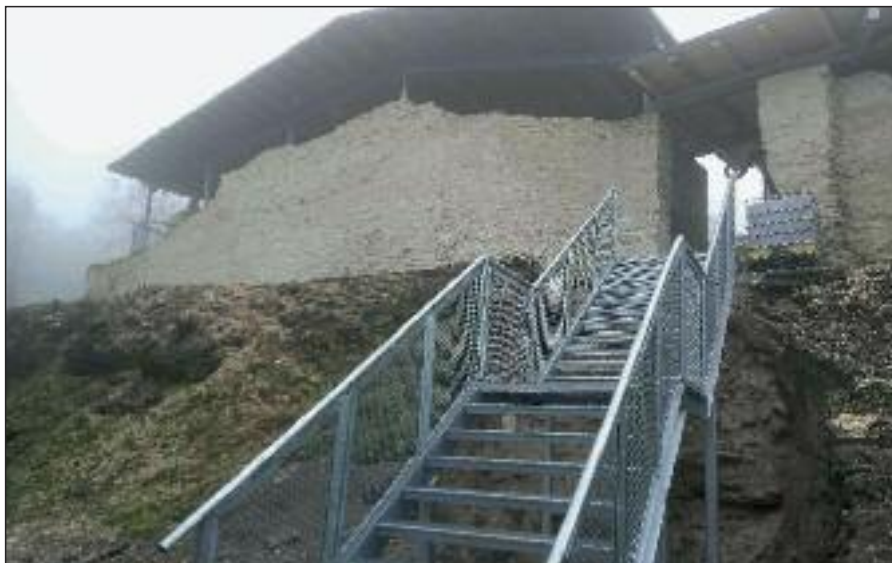
Nové kovové vstupní schodiště
