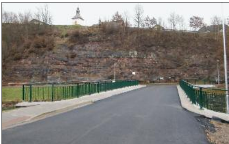
Před Vánoci byl opravený most uveden do předčasného užívání
