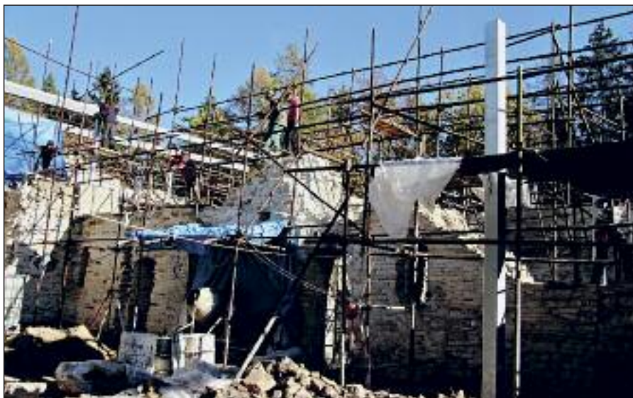
Bourání trubkového lešení
