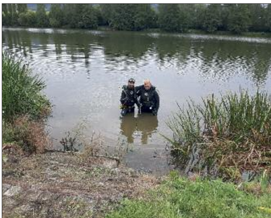
Výměna odtokové mříže na Podhájí v Batňovicích
