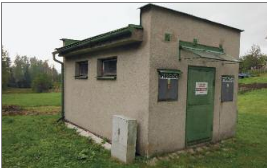
V tlakové stanici obecního vodovodu na Popluží dojde v roce 2021 ke kompletní výměně technologie
