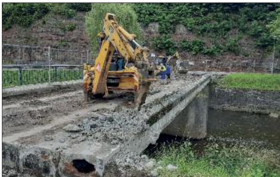
Bourání betonových říms
