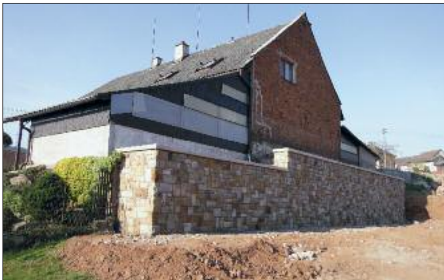
Za obecním úřadem u Kubečků byla vybudována mohutná opěrná zeď
