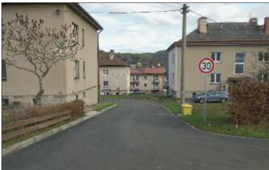
Pohled na novou asfaltku kolem bytovek
