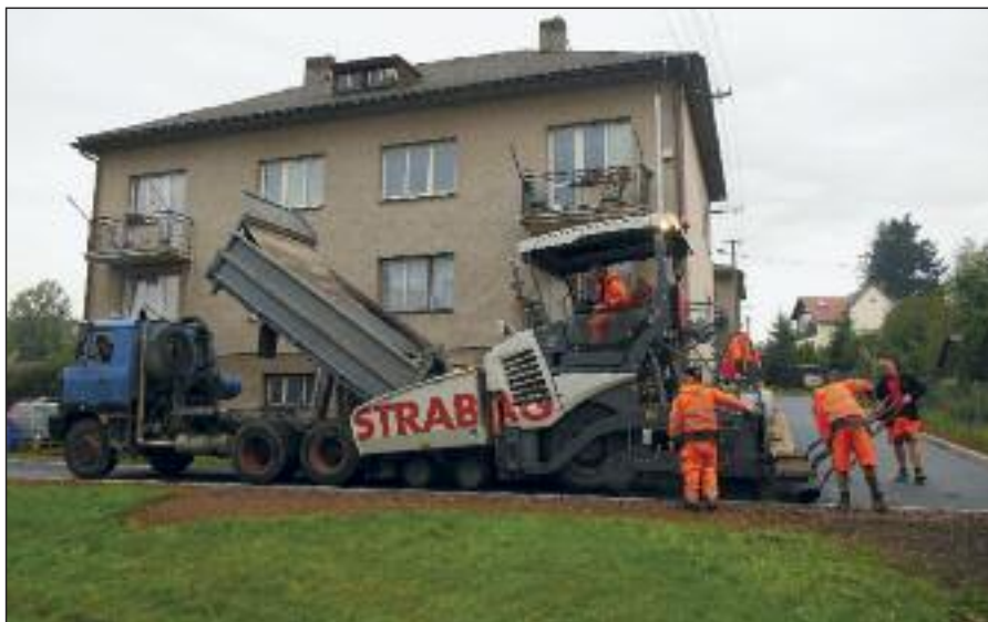
Pokládka asfaltového povrchu
