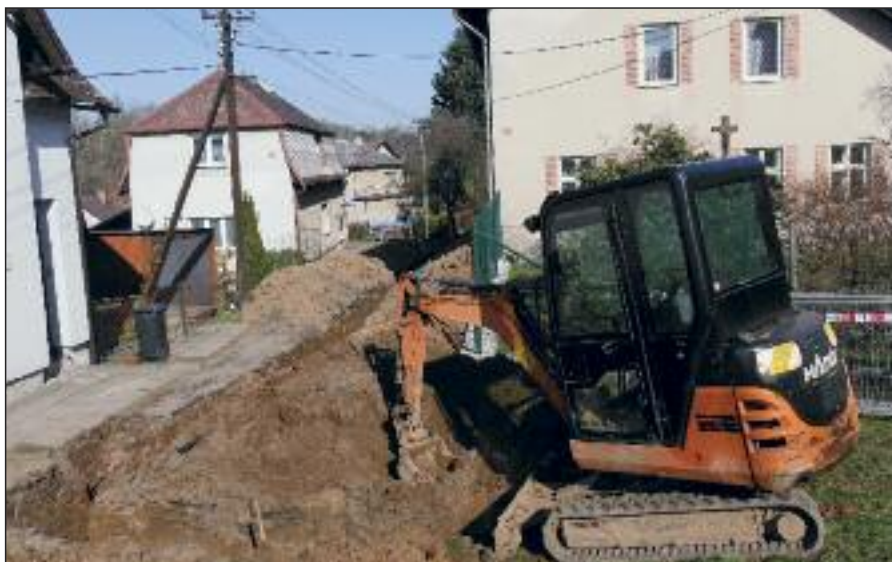
Výměna vodovodního potrubí na Hořejším konci
