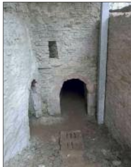
Opravený portál jižního sklepa
