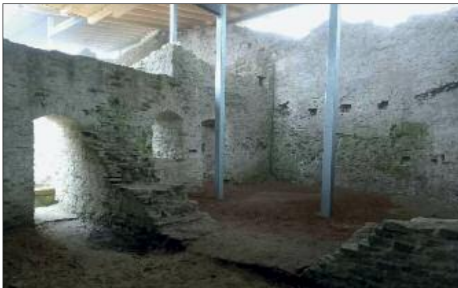
Opravený severovýchodní sál
