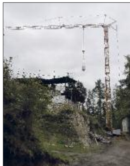
Bez jeřábu by stavební práce na hradě nebylo možné zrealizovat
