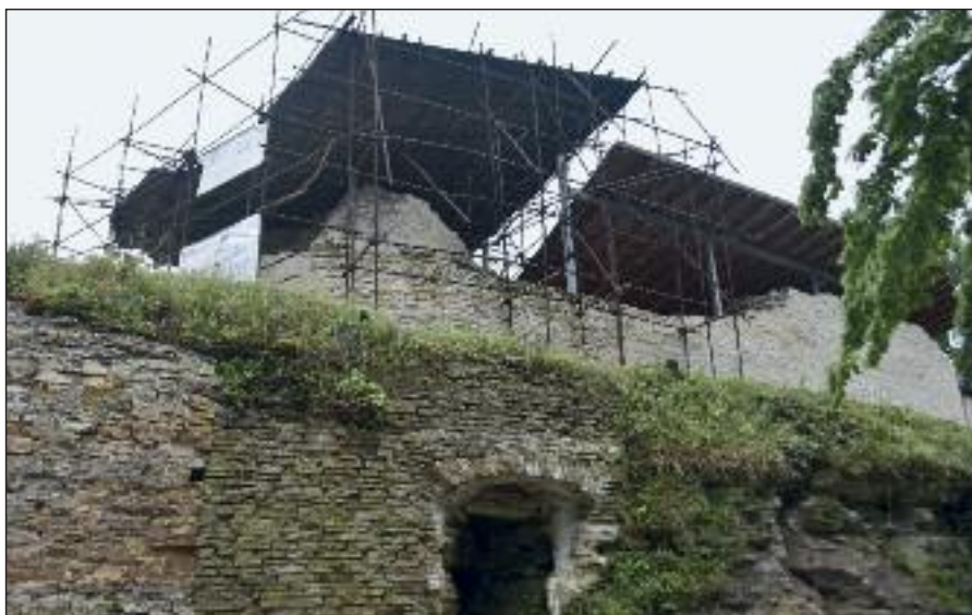
Pohled na ještě původní trubkové lešení
