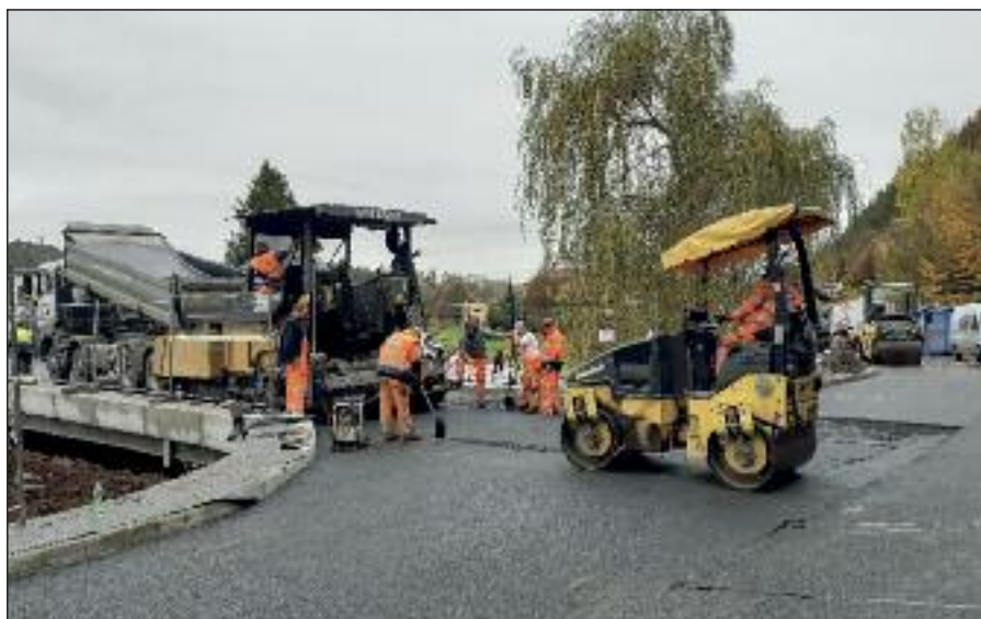
Pokládka asfaltového povrchu na mostě a předmostí
