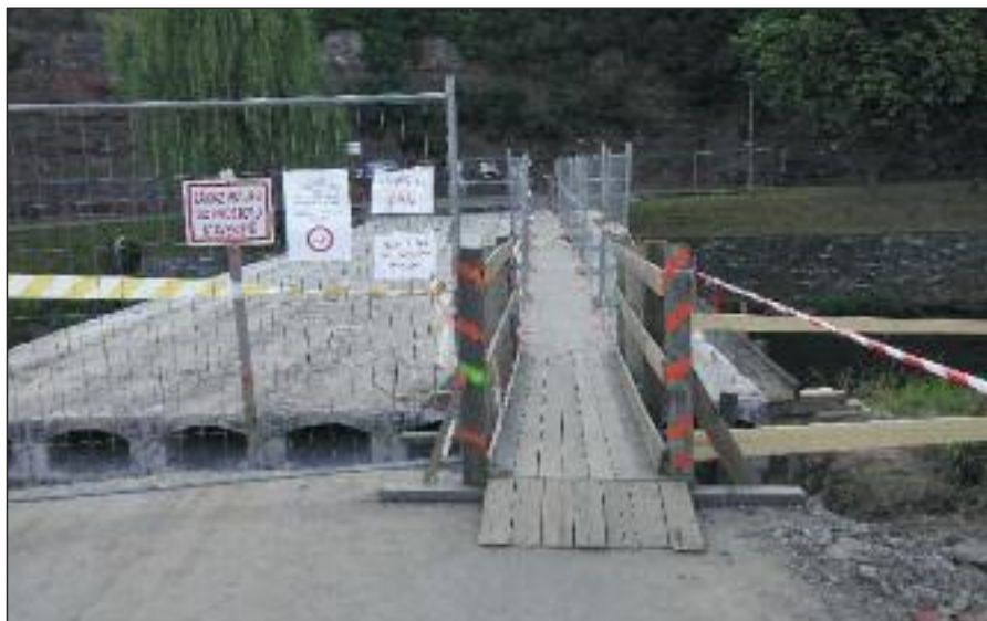
Při opravě mostu byl po většinu času zachován provizorní průchod
