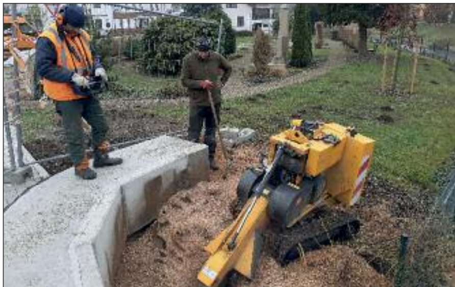
Frézování pařezu smuteční vrby v parku, která musela ustoupit opravě mostu
