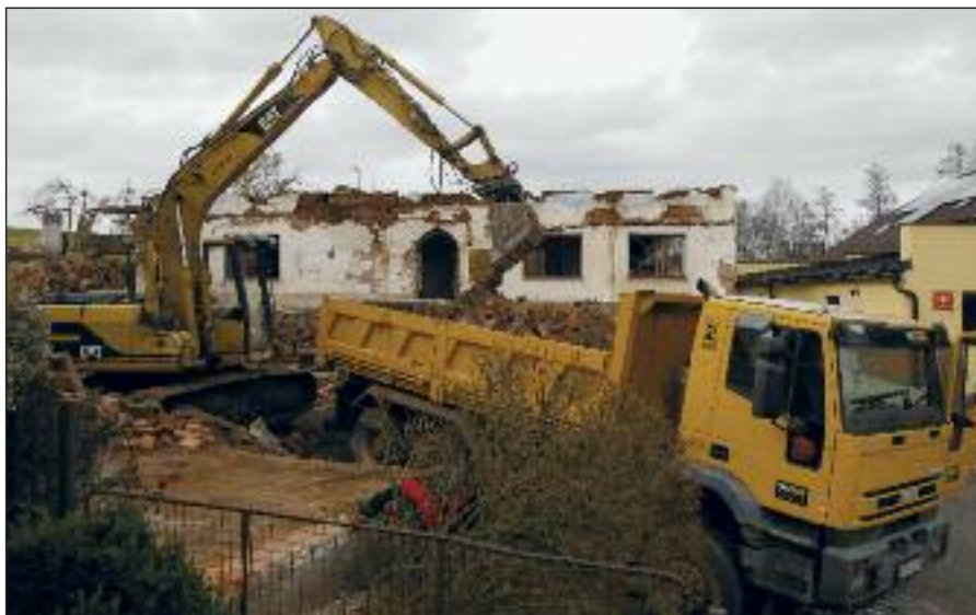
Demolice domu č.p. 59 za obecním úřadem
