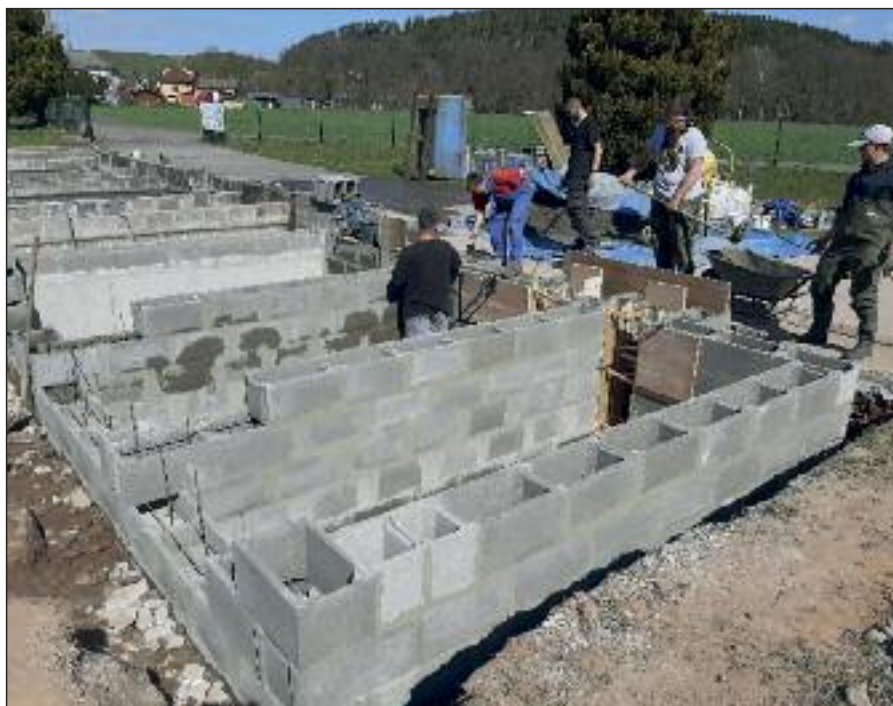
Rekonstrukce rybochovných zařízení
