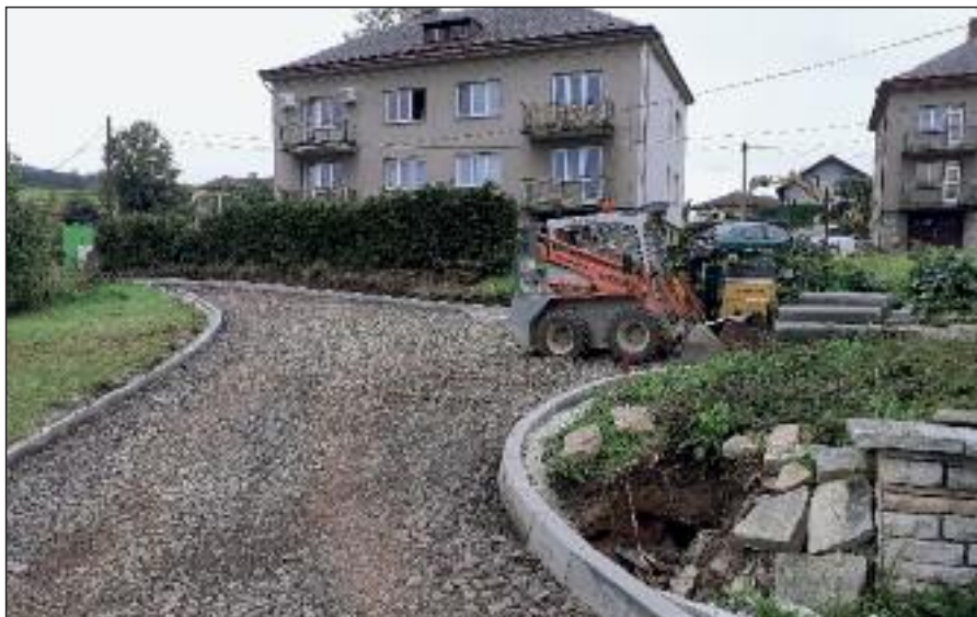
Na zhutněné šterkové podloží byly položeny dvě vrstvy asfaltu
