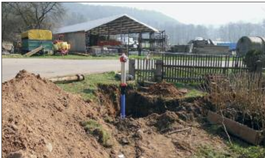
Na křižovatce u Horáků došlo k výměně nadzemního hydrantu
