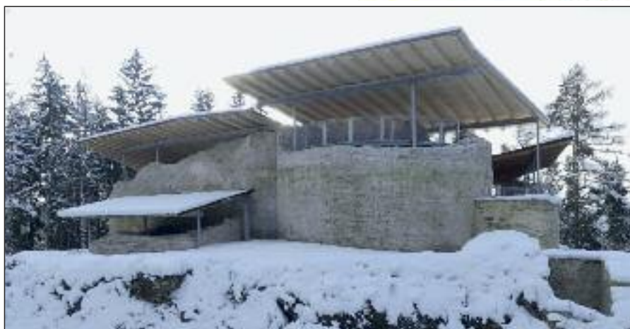
S příchodem zimy byly na Vízmburku dokončeny rozsáhlé stavební práce
