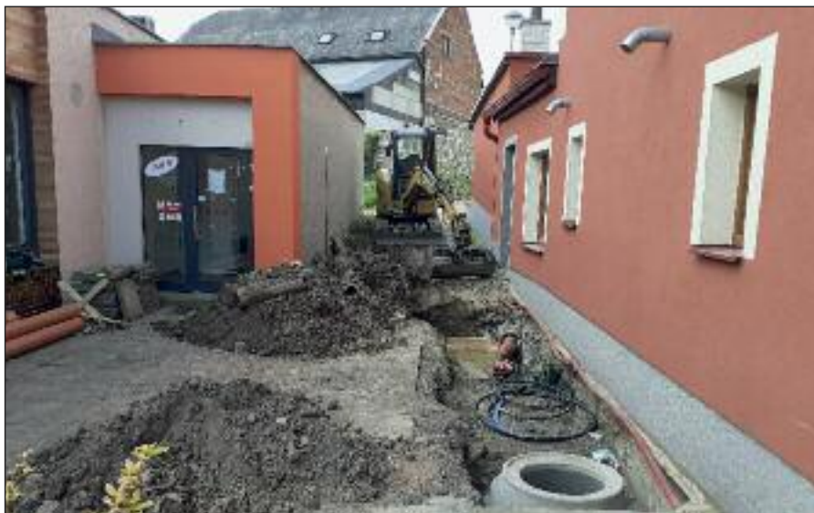
Nová kanalizace ke stavebním parcelám začínala před obecním úřadem
