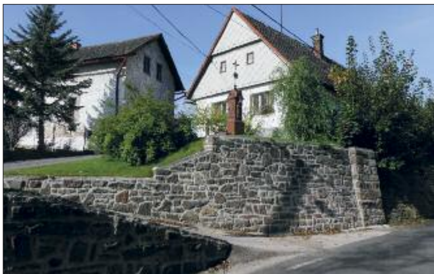
Kamenná zeď podél hlavní silnice byla přestavěna
