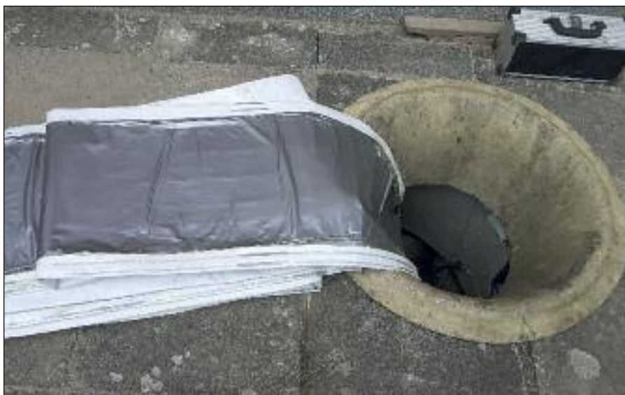
UV rukávem byla vyložkována kanalizace vedle obecního úřadu
