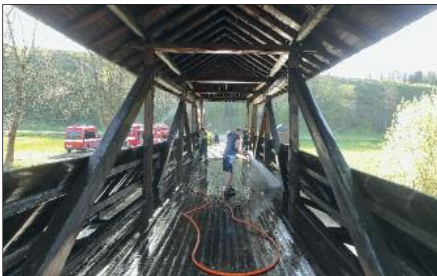
Dřevěnou lávku je potřeba každý rok opláchnout vodou
