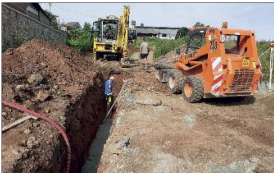
Budování nové kanalizace za obecním úřadem
