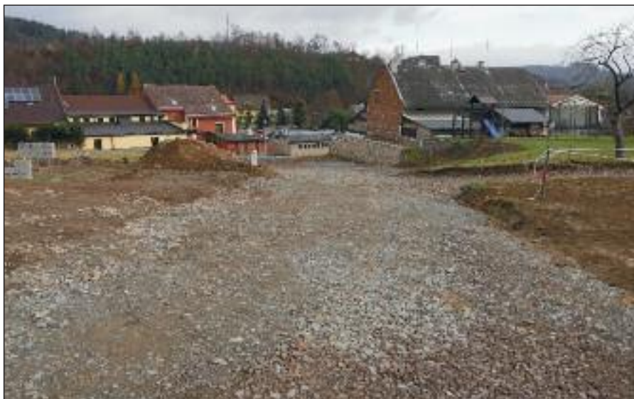
Nová štěrková komunikace ke stavebním parcelám za obecním úřadem
