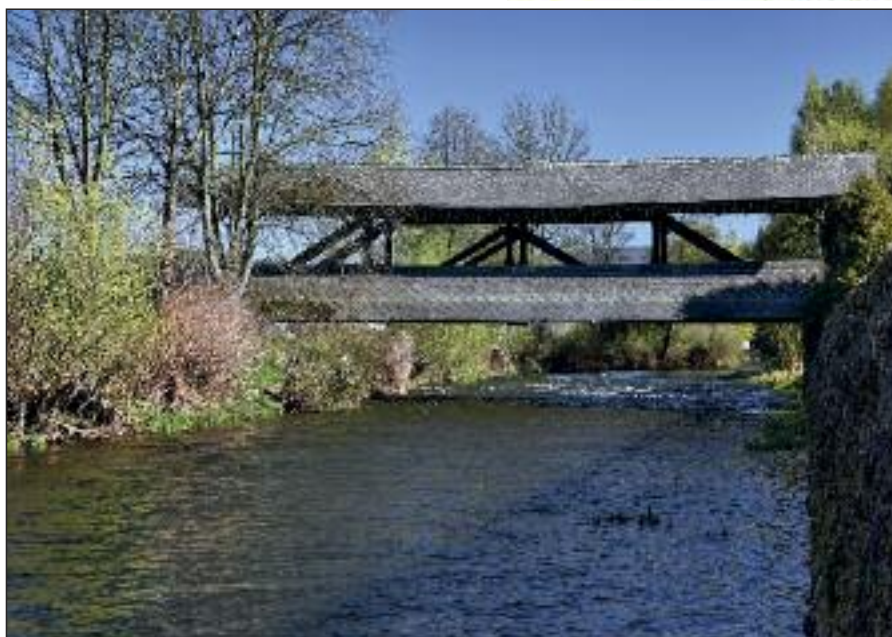
Dřevěná lávka projde rozsáhlou opravou a bude přemístěna
