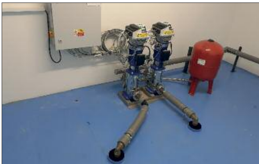
Dvě nová celonerezová vertikální vícestupňová čerpadla
