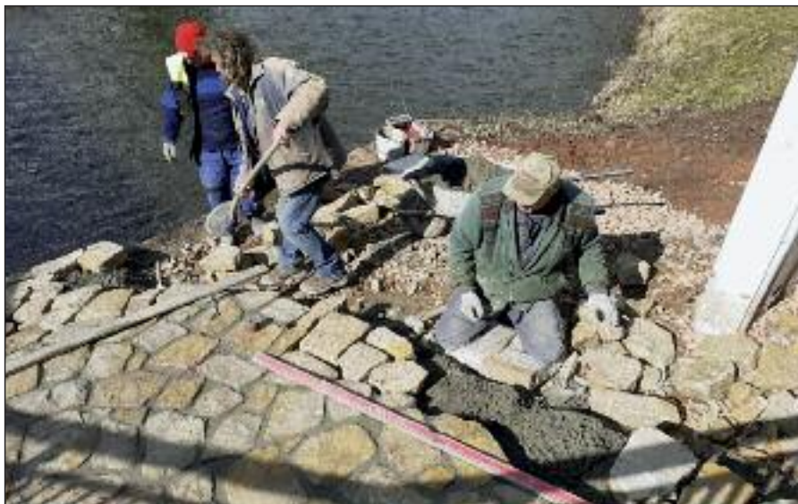
Zpevnění svahu po obou stranách mostu pískovcovou dlažbou do betonu
