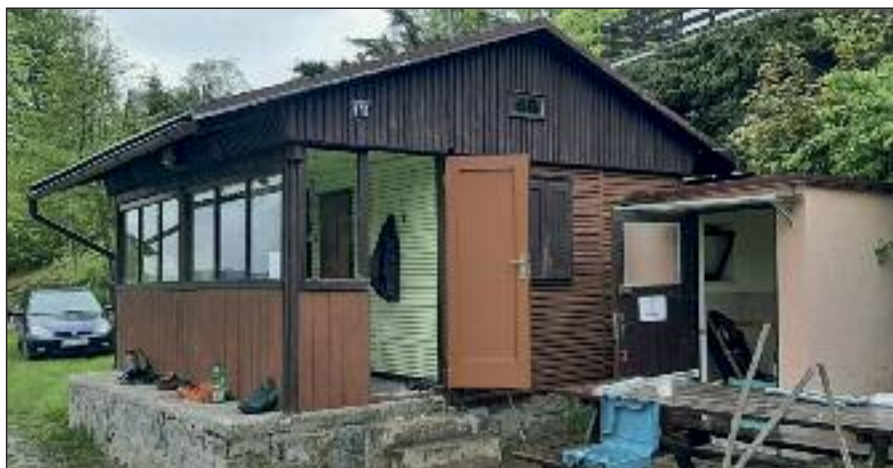
Rekonstrukce dvou chatek na Podhájí
