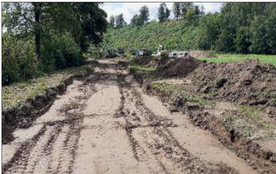
Po skrývce bylo podloží zhutněno
