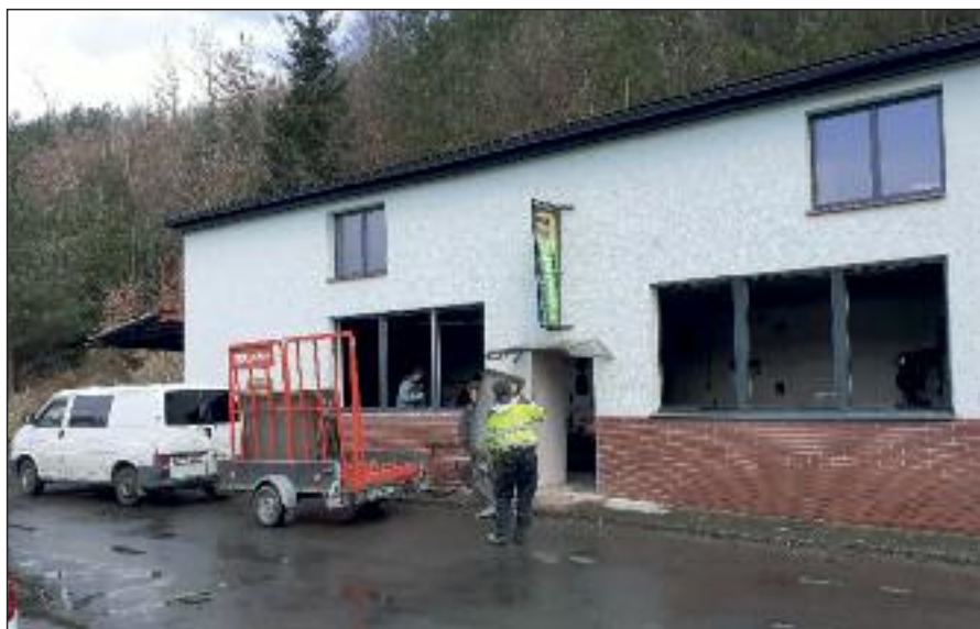
Výměna oken a vchodových dveří v obecních garážích naproti škole
