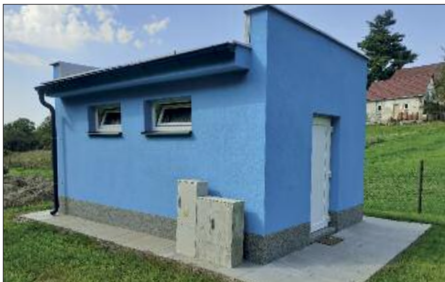
Tlaková stanice po celkové rekonstrukci
