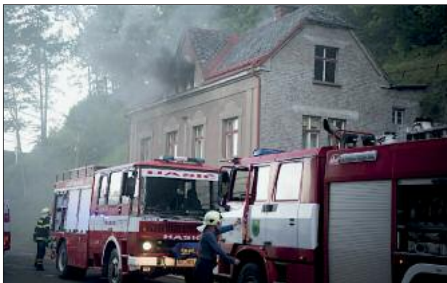
Požár patrové budovy
