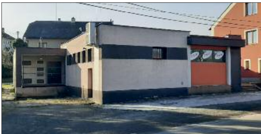
Objekt bývalé prodejny připravený k rekonstrukci
