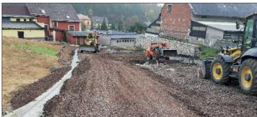
Úprava šterkového povrchu a osazení obrub
