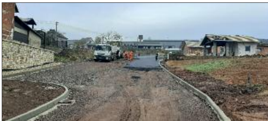
Pokládka první vrstvy asfaltového koberce
