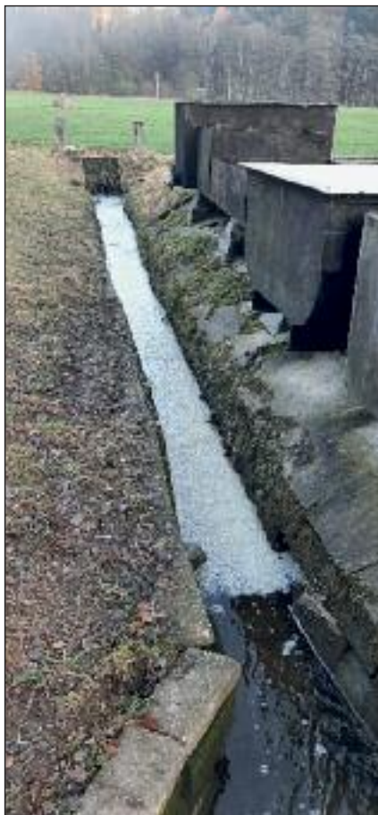
Odtokový kanál z rybníka Jindra před opravou
