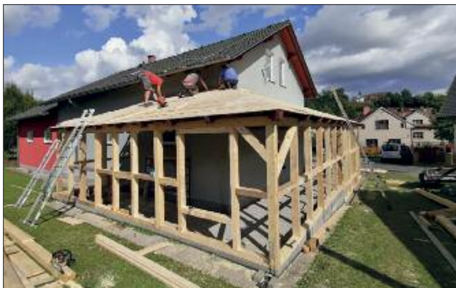
Výstavba hasičského přístřešku
