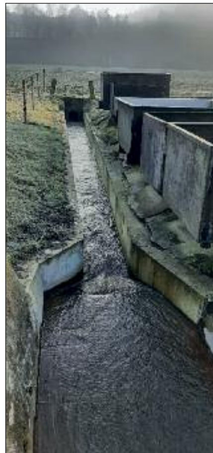
Odtokový kanál po rekonstrukci
