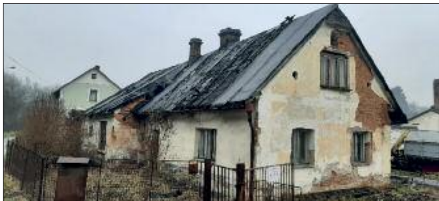
Stavební objekt č.p. 89 je součástí bývalého zahradnictví a bude určen k demolici
