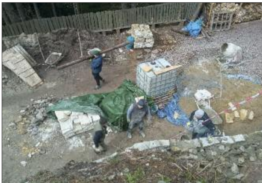
Ani v roce 2022 se stavební práce na hradě nezastavily
