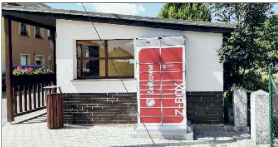
Z-BOX vedle autobusové zastávky u obecního úřadu
