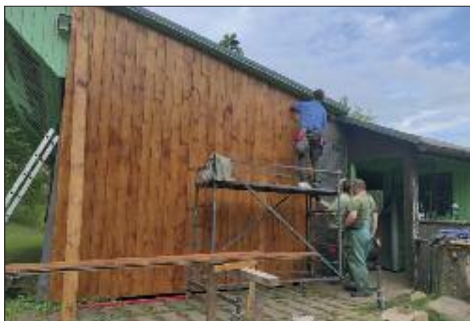
Rekonstrukce chaty na Tylově paloučku
