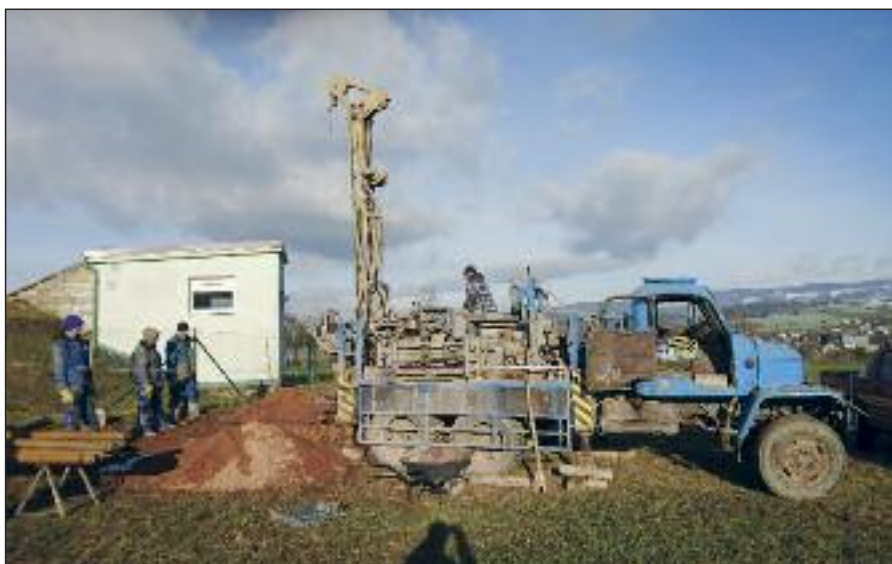
Vrtání hydrogeologického průzkumného vrtu na Králově kopci
