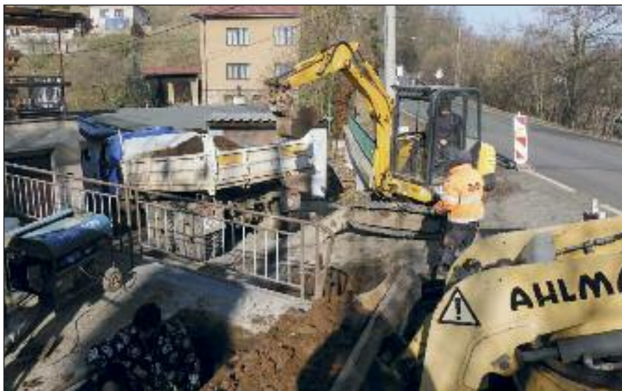
V loňském roce došlo k výměně hlavního řádu obecního vodovodu až k Zimovem
