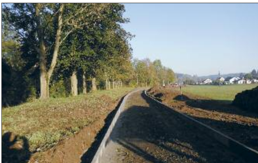
Cyklostezka je ohraničena betonovými obrubníky
