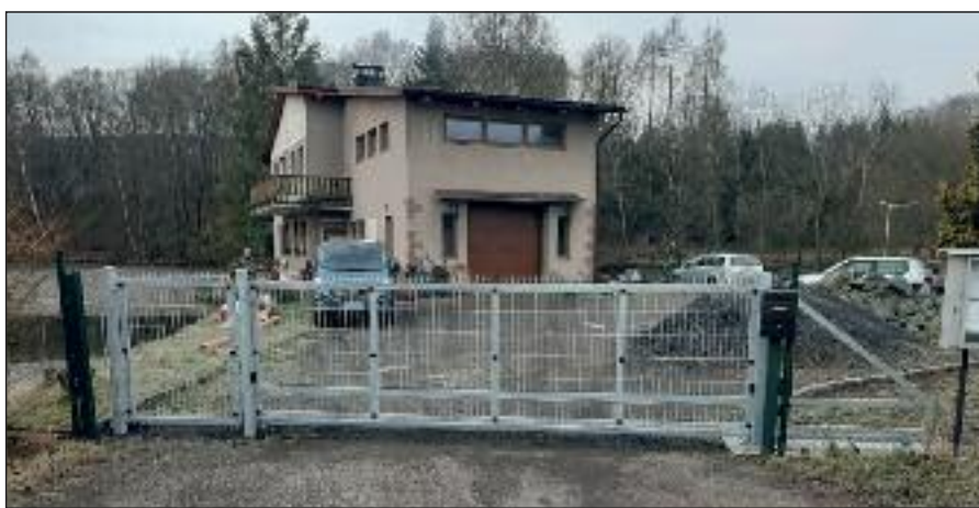
Nová pojezdová brána na dálkové ovládání
