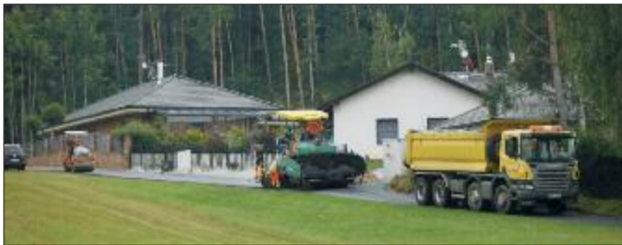
Prodloužení asfaltové komunikace za Výsluní
