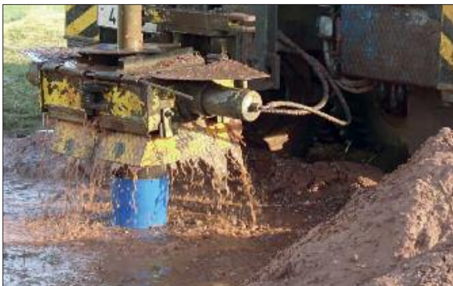
Zdroj podzemní vody byl navrtán v hloubce cca 45 m
