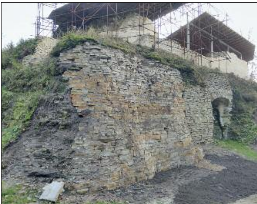
Nová opěrná zeď zpevnila skálu u vlčí jámy
