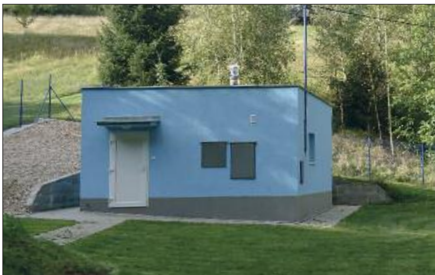
Čerpací stanice obecního vodovodu v Muchově
