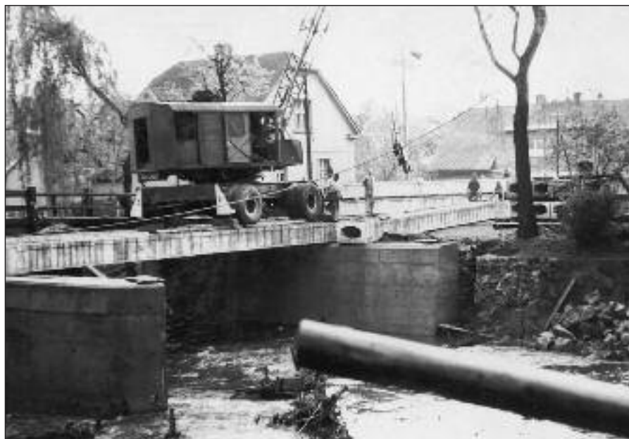
Betonový most ve Vsi byl vybudován v roce 1963
